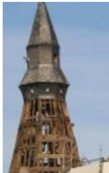
Réalisation d'une nouvelle enrayure et après révision ou remplacement, remontage sur celle-ci des montants profilés existants, des pannes et du poinçon, l'ensemble formant l'ossature des versants de la tour.
