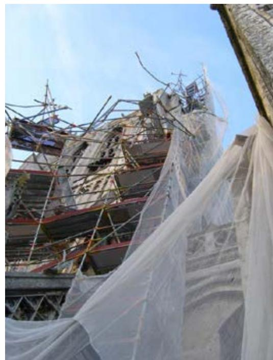
Figure 50: Conséquence d'un mauvais ancrage
