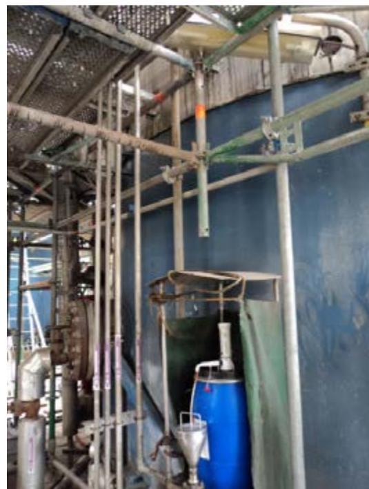
Figure 20 : Décalage de l'implantation des montants
