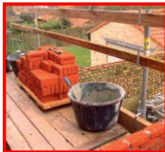
Figure 47: Exemple de charge sur tréteau
