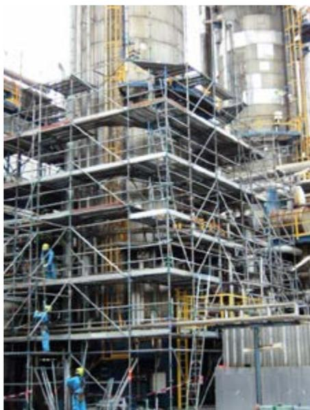
Figure 35 : échelle passerelle intégrée
