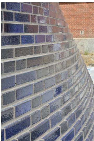
Les briques en talus, émaillées sur la tranche visible d'où une fabrication spéciale
