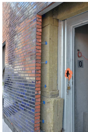
parement briques+isolant
