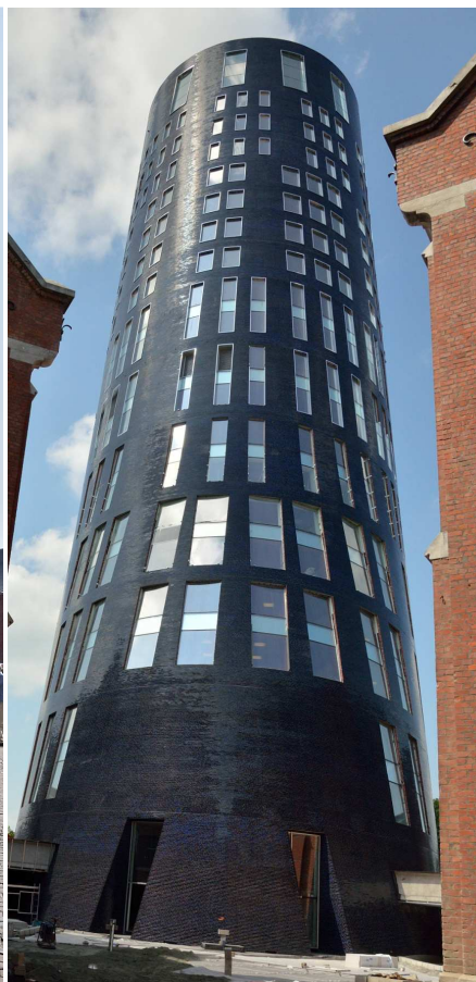
La tour Côté Nord
