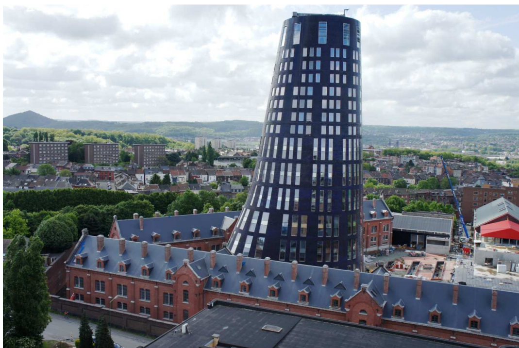
La Tour bleue, les 2 bâtiments du 19ème s, l'esplanade en cours de finition et dans le fond à droite, la construction de la cafétéria. (photo de Mr E.Colmant)
